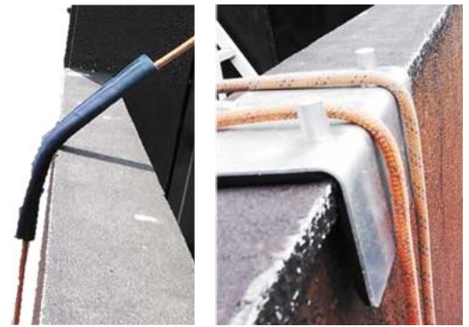
切断防止措置の例 (置き型養生) ▲
