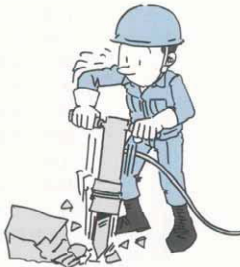
コンクリートブレイカーによる作業
